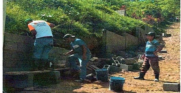
Foto 2: PROCESO DE COLOCACION DE BLOK
